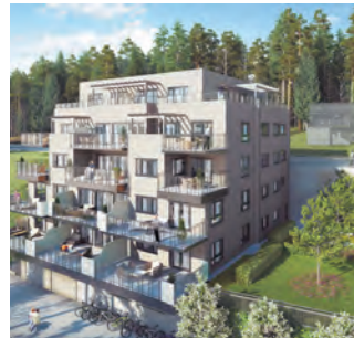
Новый кондоминиум Berges Terrasse Complex Драммен, Норвегия ECOi /Aquarea
