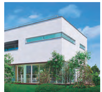
«Умный дом» Ариаке, Токио HVAC и комбинация генераторов солнечной энергии, батарей и аккумуляторов
