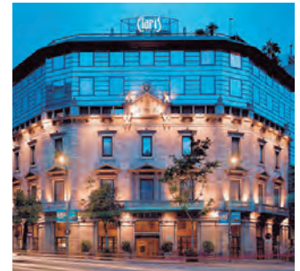
Переоборудование отеля Hotel Claris 5* Барселона, Испания ECOi
