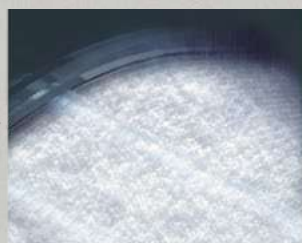
Обмерзание теплообменника
